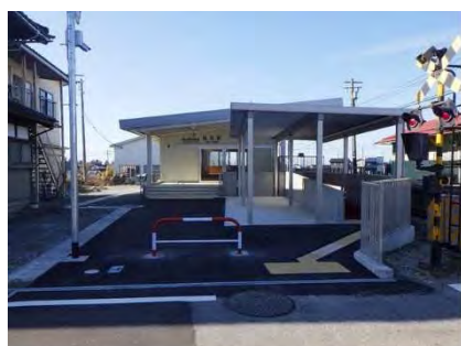
図 移設新築された荻生駅
