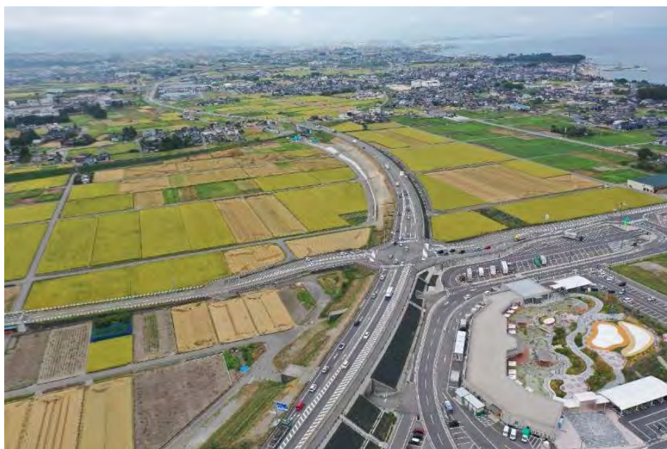
図 4車線化が進む国道8号 道の駅KOKOくろべ交差点付近
