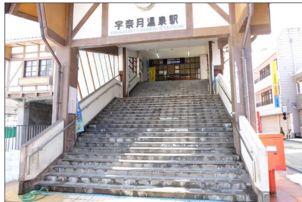
図 宇奈月温泉駅正面階段（正面・西出入口）
